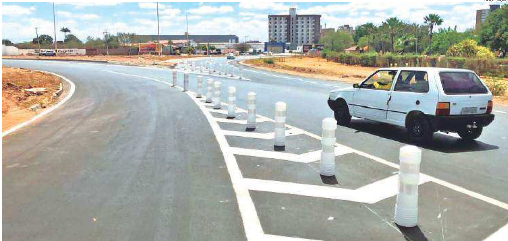
Rotatória na BR-304 em Mossoró, Oeste potiguar, é o primeiro acesso de quem chega ao Rio Grande do Norte vindo do Ceará; obra vai melhorar fluxo e segurança na região
